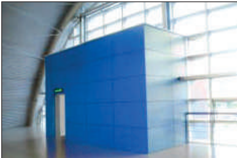
HAVAALANLARI İÇ VE DİŞ CEPHE
